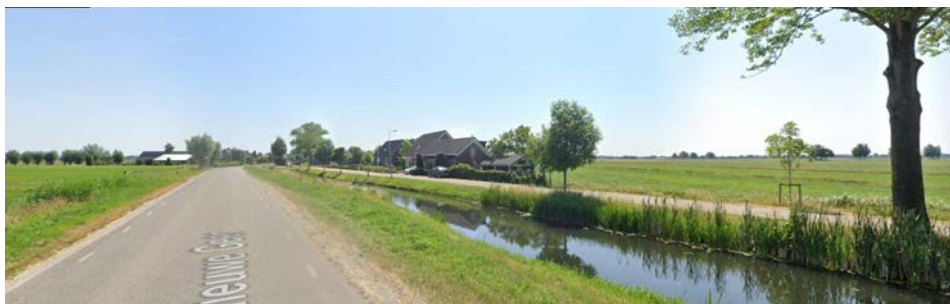
Buiten de bebouwde kom
